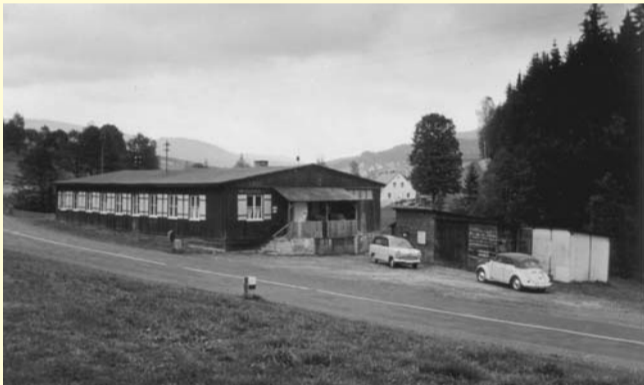
Holzbaracke im Ortsteil Rangen als Produktionsstätte der Firma „Ullrich und Hertel“.
