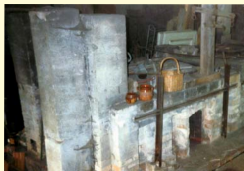
Glasofen – außer Betrieb.
